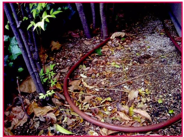
难波综合商用设施屋顶花园中水撒水装置 (雨水感知器长时间没有感知时,会从管道孔中自动渗水的“输液式撒水”)
