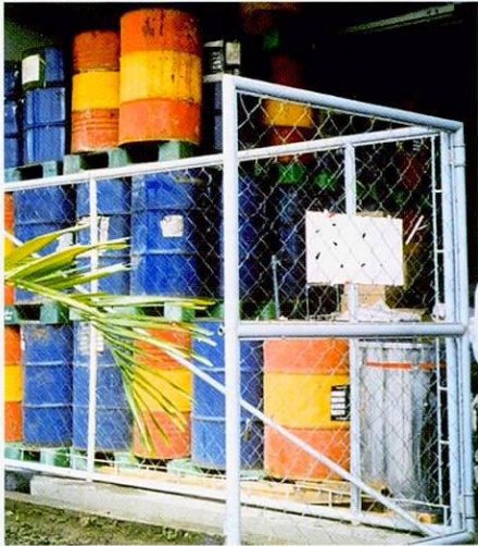
在带有屋顶的仓库保管的液体有害废弃物
