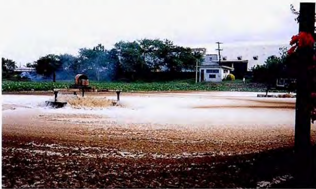
パルプ工場 排水処理装置
