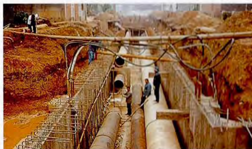
ガスの集中化工事(石炭のガス化による大気汚染対策)
