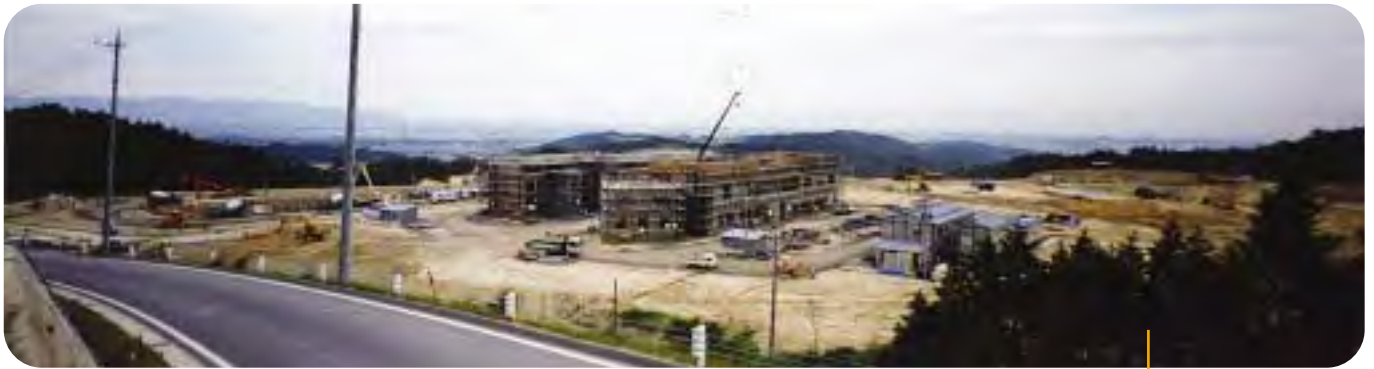
建設中の写真（5月）
