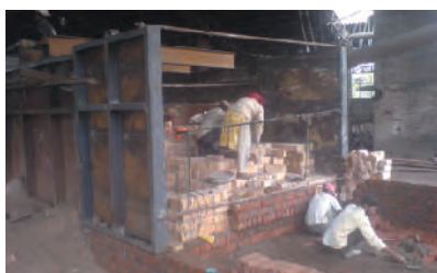
加熱炉工事
