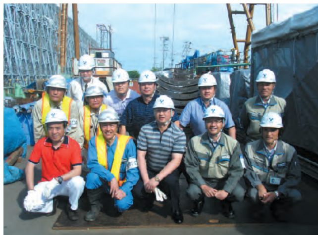
ガス導管現場
